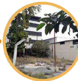
2022 situação de abandono
