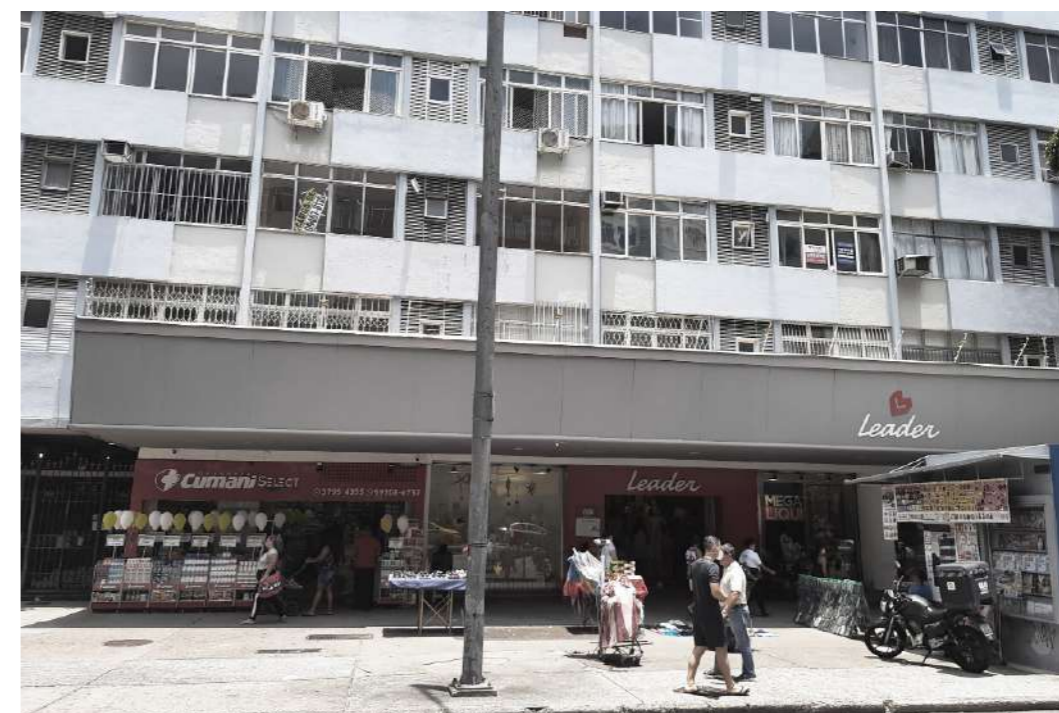
Loja de departamento. 2021. Após demolição foi construída uma loja de departamento, o comércio informal ainda se mostra presente na calçada.
