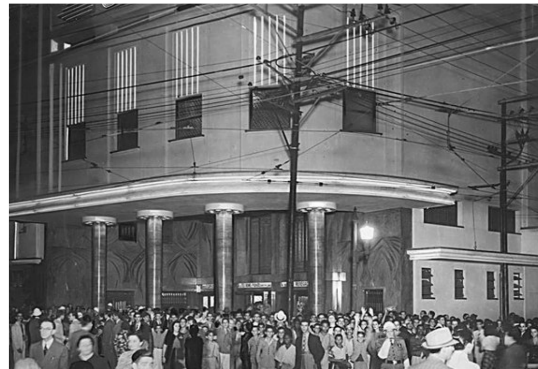
Inauguração do Cinema Carioca. 1941. Fonte: Agência O Globo. Inaugurado em 1941 com uma arquitetura art-déco, com largos pilotis em mármore e uma escadaria de corrimãos dourados no hall de entrada. Fechou em 1999 e 8 meses depois foi tombado.
