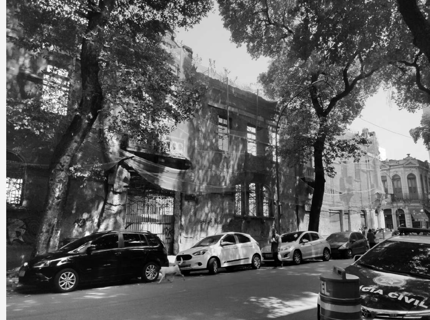
_ fachada atual da garagem poula
