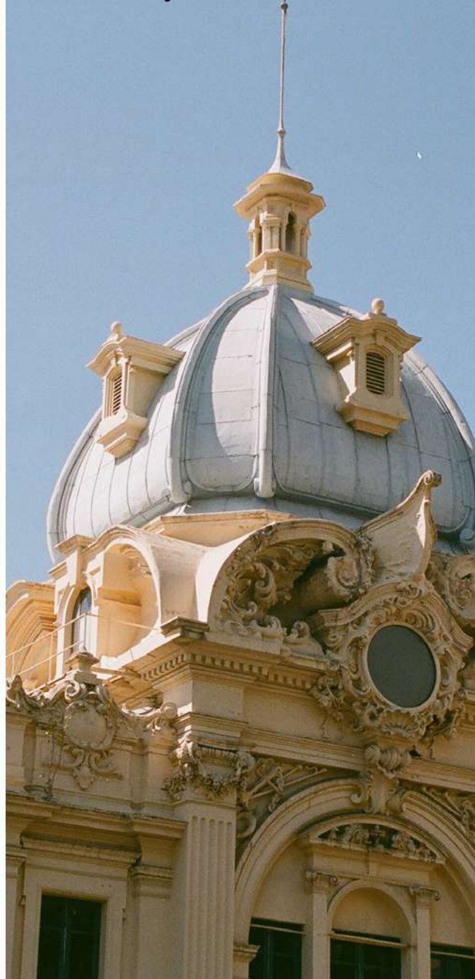
estação de barcas
