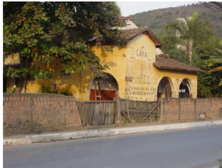
Antiga Estação de Vila de Cava, Nova Iguaçu. Um dos bens tomados reconhecidos pelo INEPAC na região. Fonte: http://www.inepac.rj.gov.br/index.php/bens_tombados/detalhar/170
