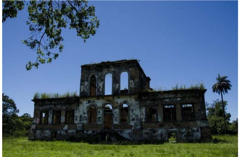
A Fazenda São Bernardino (1875), localizada no município de Nova Iguaçu, é tombada pelo IPHAN, um dos poucos objetos reconhecidos como patrimônio histórico na baixada, porém não possui o cuidado necessário e encontra-se em situação de abandono.
