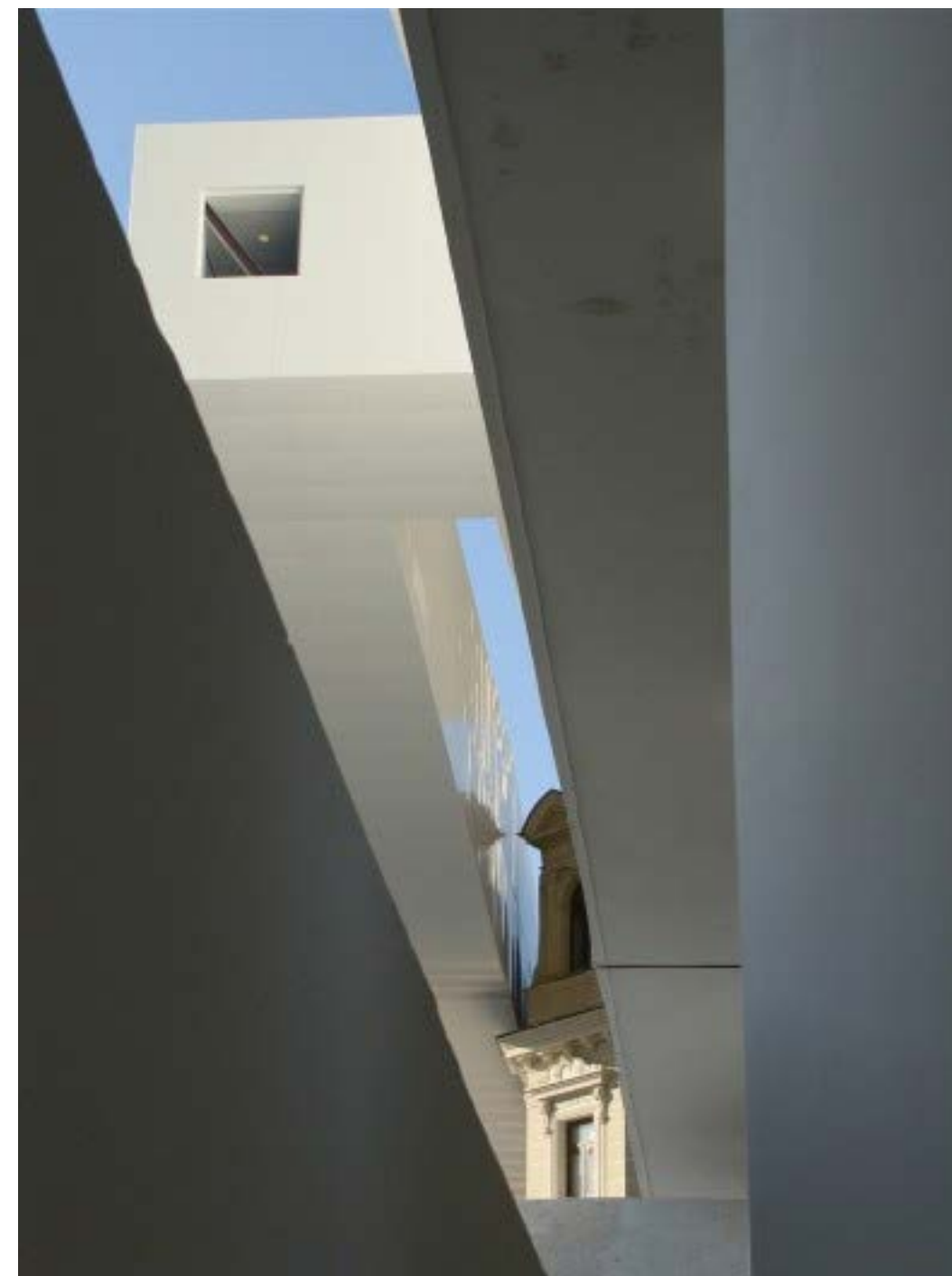
Conflito entre o novo e o existente (foto - André Reis Balsini)
