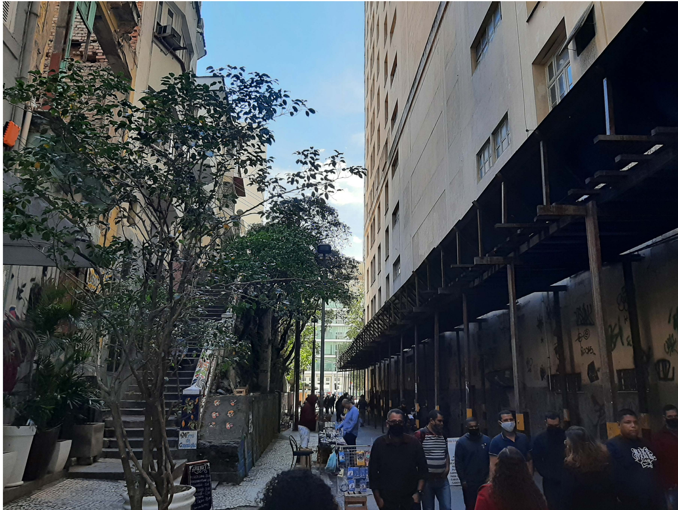
Visada da Travessa do Liceu sentido MAR a partir da Av Rio Brando. A esquerda a escadaria que dá acesso ao Morro da Conceição, na travessa comércio informal e a direita observa-se o térreo do A Noite completamente fechado. A sombra projetada pelo edifício é percebida pela claridade refletida no MAR. Foto tirada em uma sexta-feira de julho próximo das 13h, horário em que trabalhadores do centro saem para almoço.
