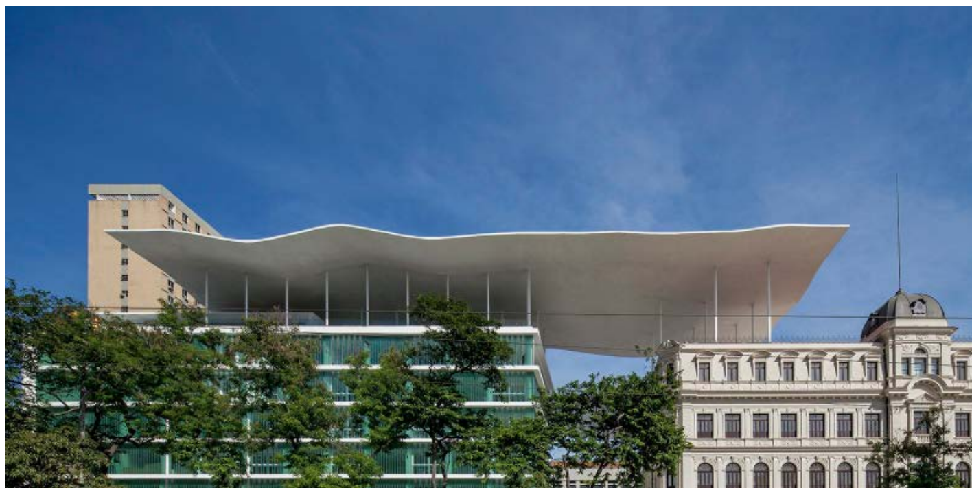
Cobertura ondulada de concreto conectando a Escola do Olhar ao Palacete Dom João, o prédio da Polícia e a antiga rodoviária do Rio (foto - Leonardo Finotti)
