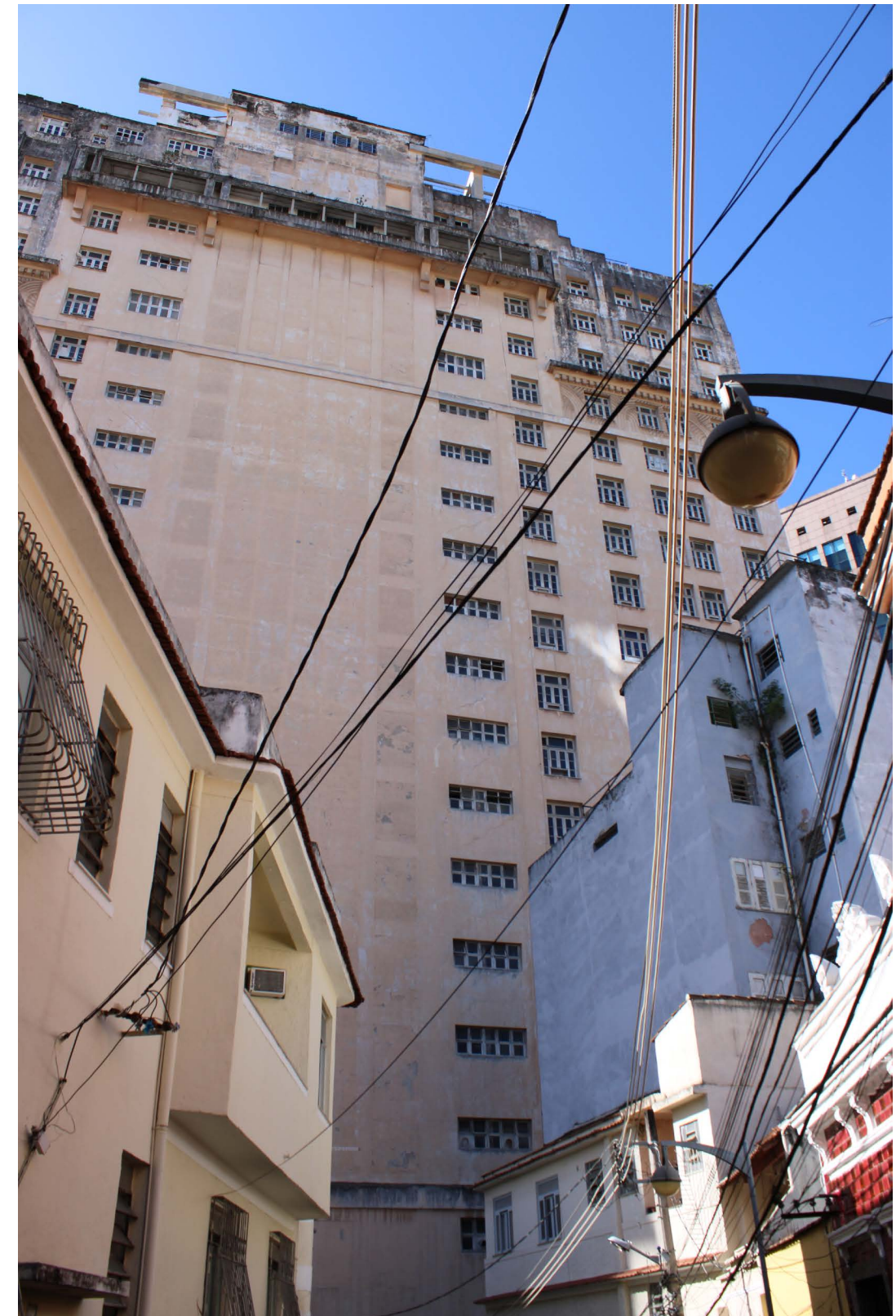
Fachada do A Noite observada a partir do Morro da Conceição. A faixa de fachada cega abriga o núcleo de circulação vertical no interior do edifício.
