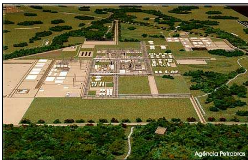
Figura 11. Representação de vista aérea das instalações futuras do Comperj. Fonte: PETROBRAS SA
