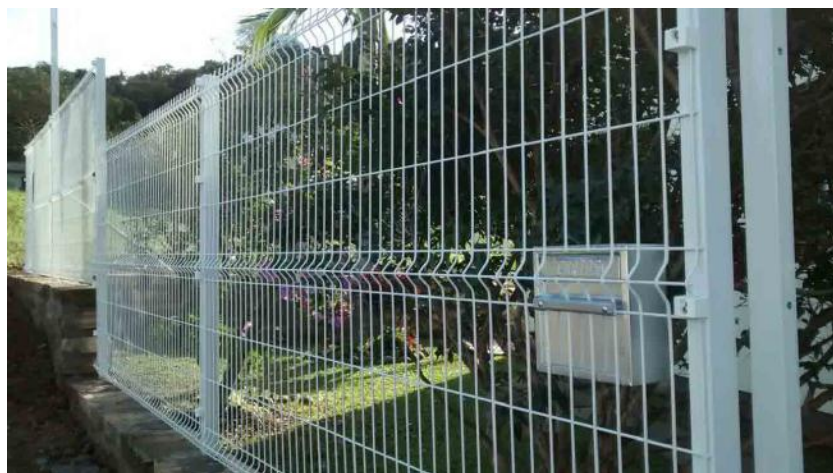
Figura 21: cerca de aço galvanizado.
