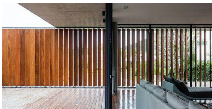
Figura 32: Elemento arquitetônico Brise-soleil.
