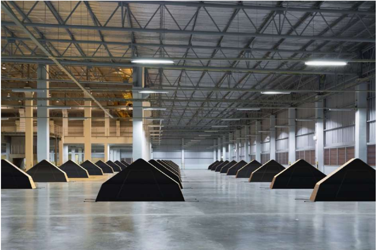
Figura 49 - Tenda Reverse instaladas em galpões
