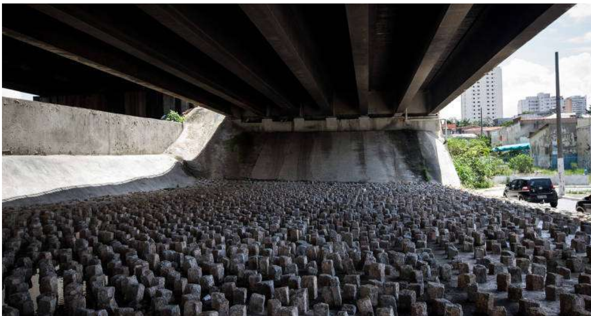
Figura 2 - Pedras instaladas em um viaduto
