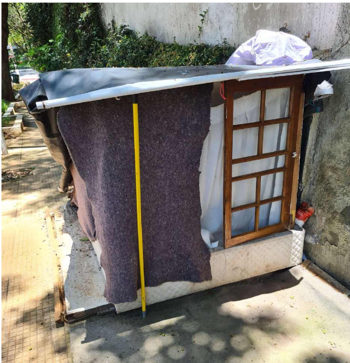
Figura 12 - Abrigo improvisado reformado
