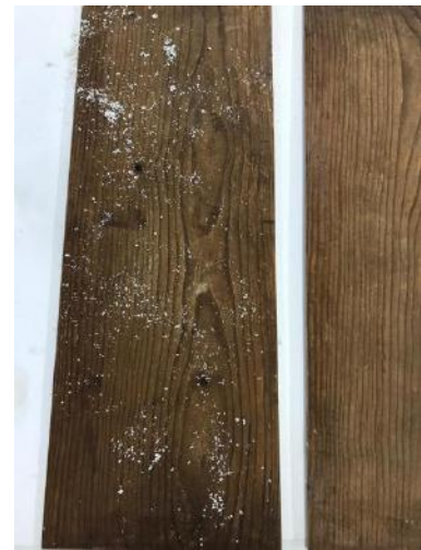
Figura 76 - Limpeza mecânica com pó de borracha
