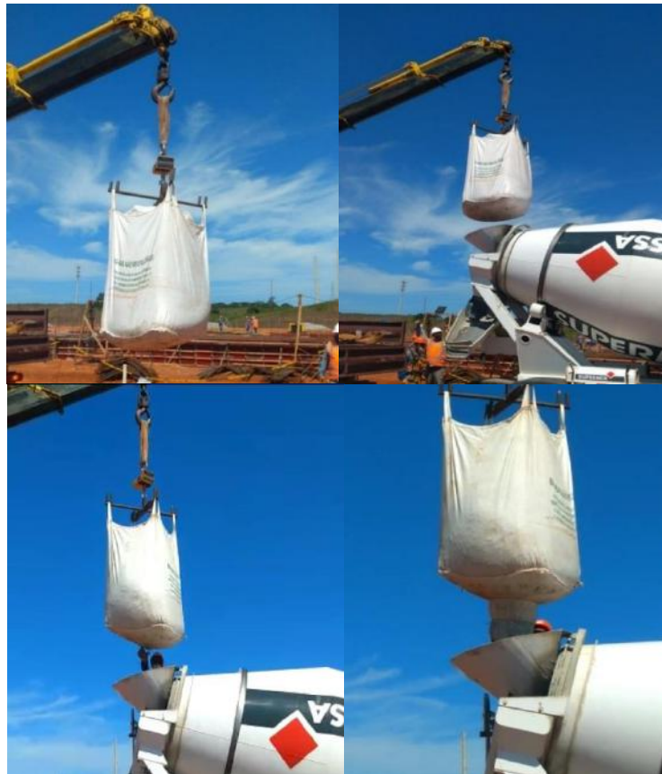
Figura 19 – Passo a passo do despejo de gelo na betoneira
