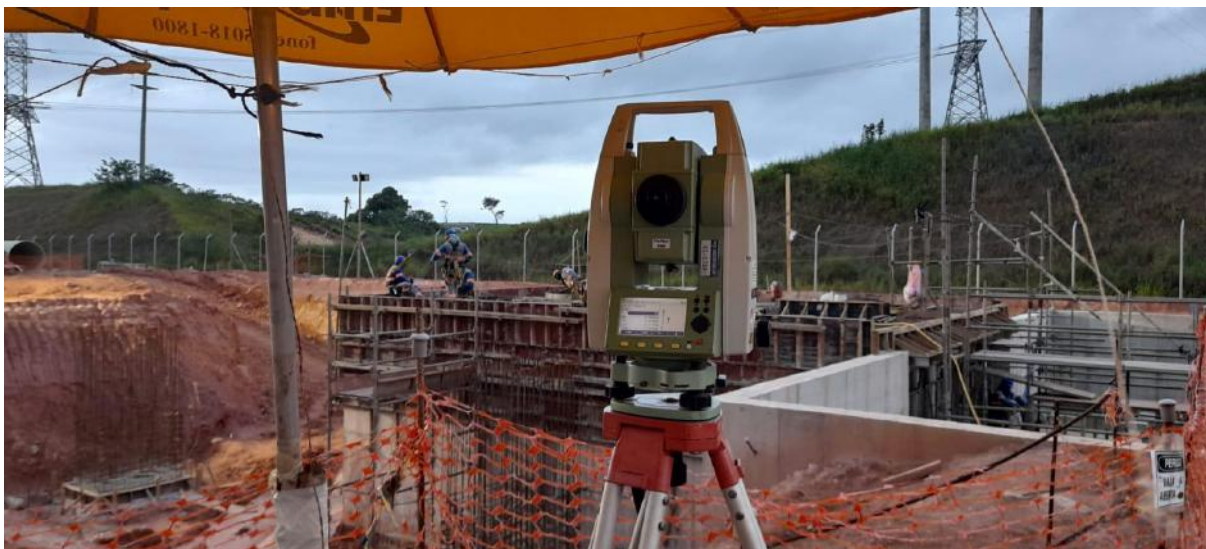
Figura 10 – Estação total utilizada para conferências de topografia
