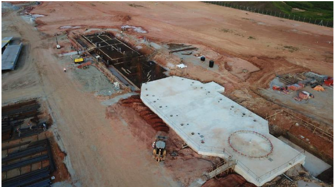
Figura 5 – Vista superior da base da turbina antes do concreto
