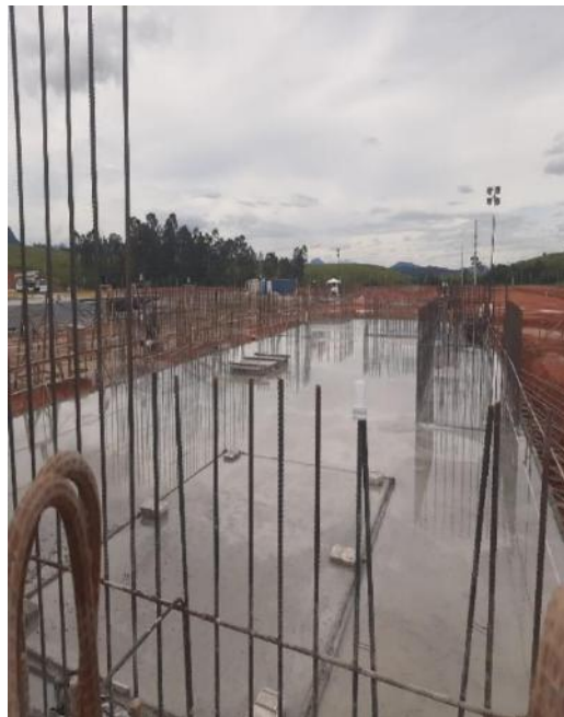
Figura 29 – Cura úmida com lâmina d'água da base da turbina
