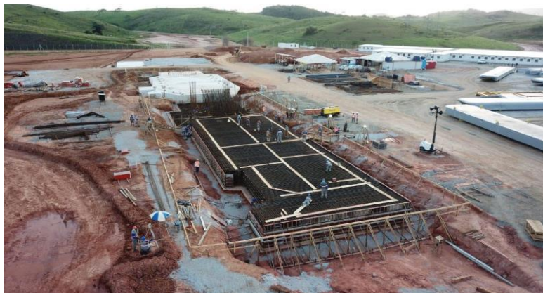
Figura 25 – Vista superior da peça antes da finalização
