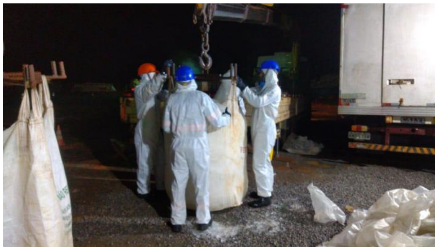
Figura 24 – Içamento do gelo com munck para mistura no caminhão betoneira
