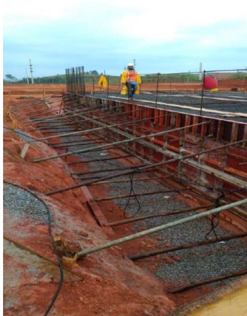
Figura 8 – Montagem da armação
