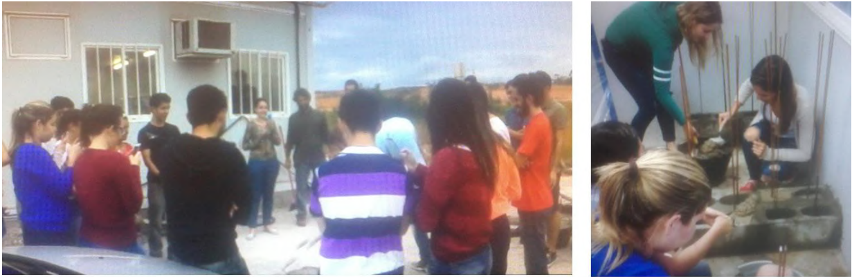
Figura 6.5 – Alunos e professor reunidos para início da construção do laboratório da engenharia civil.
