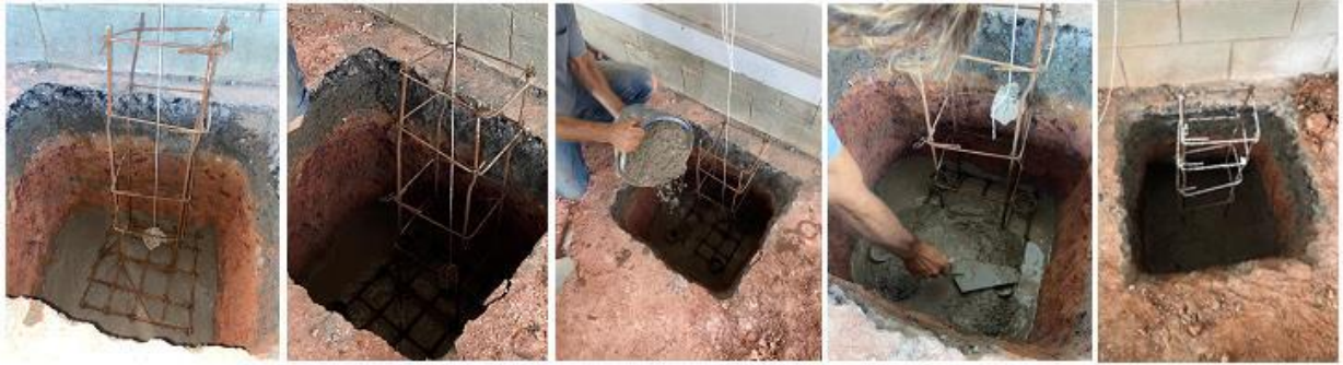
Figura 6.22 – Instalação da armadura e concretagem da laje da sapata.
