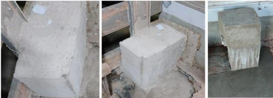
Figura 6.24 – Estruturas de apoio finalizadas.
