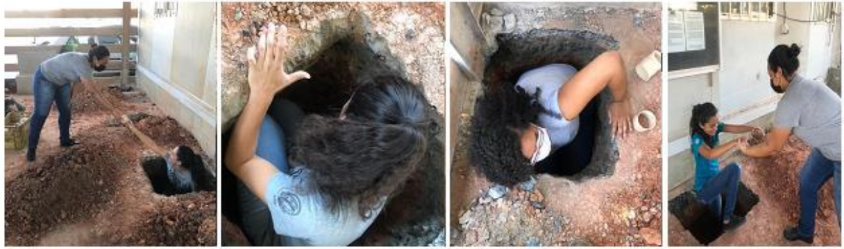
Figura 6.19 – Finalização da escavação com limpeza final.
