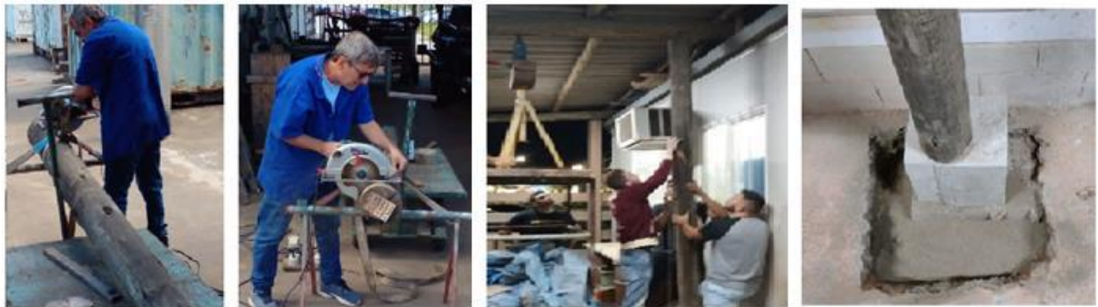
Figura 6.25 –Corte das madeiras dos pilares e instalação dos mesmos.
