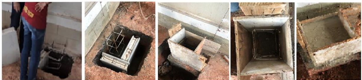
Figura 6.23 – Formas utilizadas: placas pré-moldadas de concreto e madeiras.
