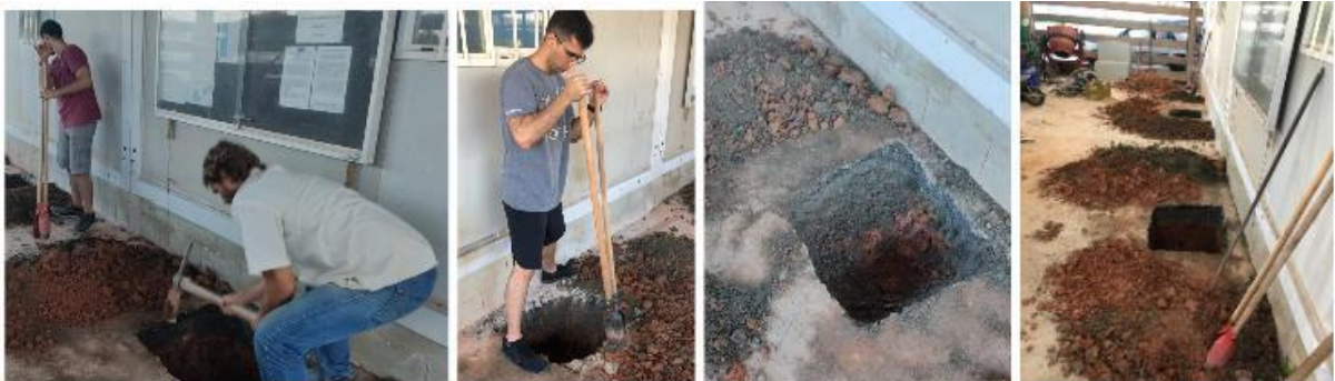
Figura 6.18 - Sequência da escavação dos buracos para as sapatas com ferramentas pesadas.
