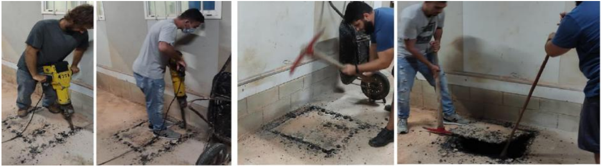
Figura 6.17 - Corte da camada inicial de asfalto de uma das sapatas.
