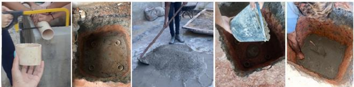
Figura 6.20 – Gabaritos de PVC e colocação do concreto magro.
