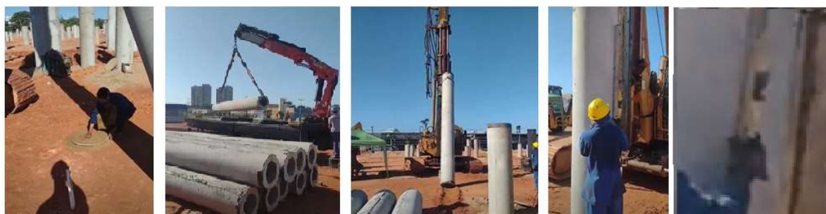
Figura 4-14 - Locação de estacas com auxílio de equipe de topografia
