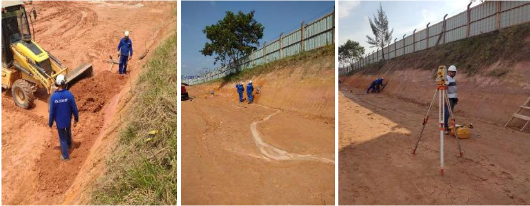
Figura A. 14 - Corte e marcação dos furos para os grampos
