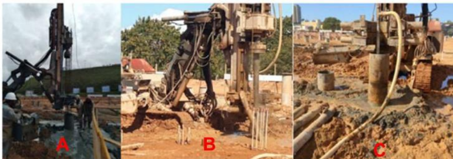
Figura A. 6 - Injeção de argamassa (A) e retirada da tubulação (B e C)
