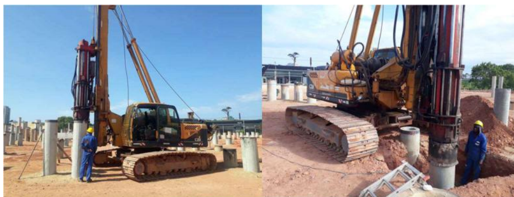
Figura A. 11 - Bate estacas utilizado para os ECDs
