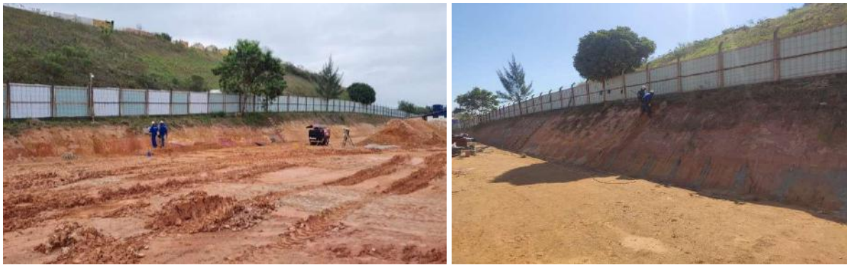
Figura A. 15 – Execução dos grampos
