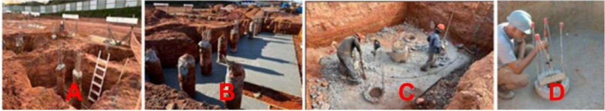
Figura 4-17 – Escavação (A), concreto magro (B), arrasamento das estacas (C) e medição de excentricidade (D)
