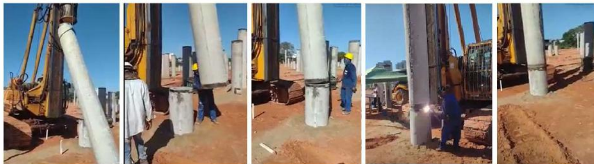
Figura 4-15 - Solda entre estacas
