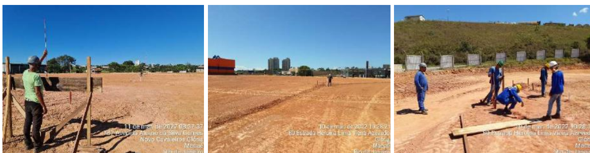
Figura 4-13 - Locação de estacas com auxílio de equipe de topografia
