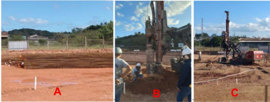
Figura A. 4 – Armadura (A), locação e posicionamento (B e C)
