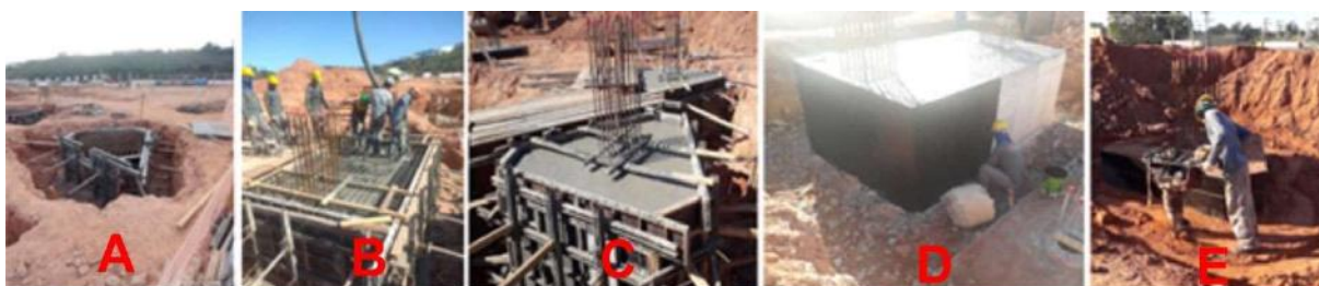
Figura 4-19 – Travamento (A), concretagem (B e C), impermeabilização (D) e reaterro dos blocos (E)
