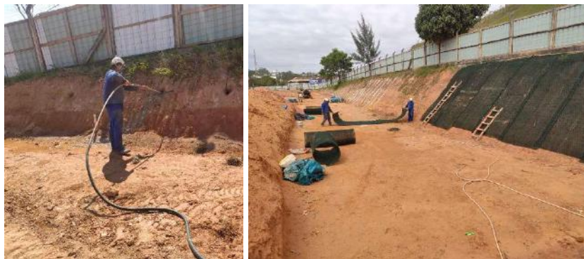
Figura A. 16 – Injeção da nata e aplicação da tela
