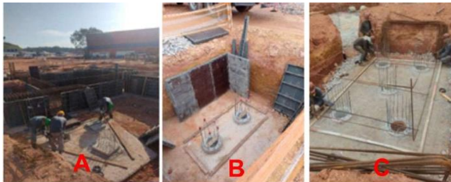
Figura 4-18 – Gabarito (A), montagem de formas (B) Armação de Blocos de coroamento (C)
