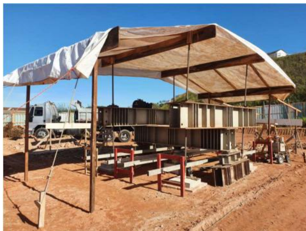
Figura A. 8 - Estaca E-14A Ensaçada
