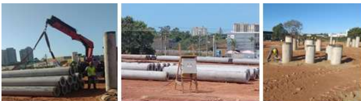
Figura 4-8 - Estacas pré-moldadas utilizadas na obra
