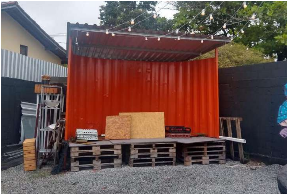
Figura 34 - Palco criado através da lateral cortada do container
