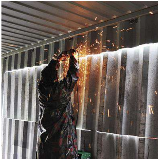
Figura 27 - Corte da lateral de um container
