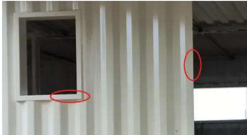
Figura 28 - Diferença entre superfícies sem e com moldura
