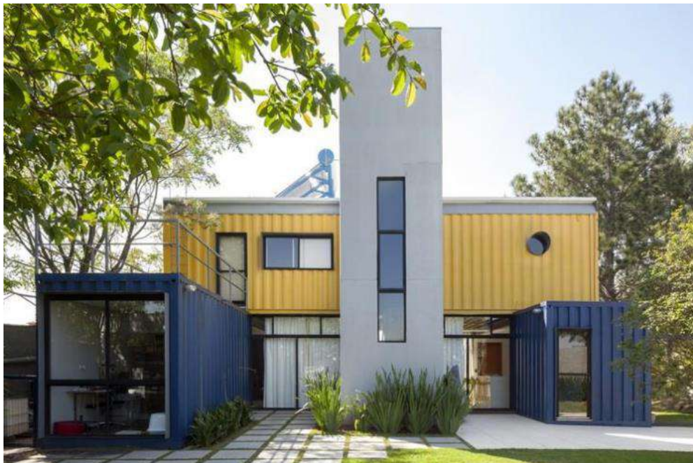
Figura 20 - Casa-container no Brasil, localizada em Cotia, São Paulo
