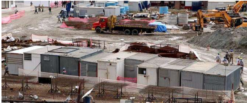
Figura 18 - Containers no canteiro de obra
