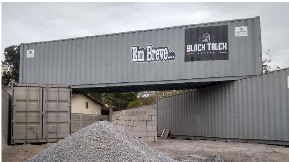
Figura 32 - Posicionamento dos containers
