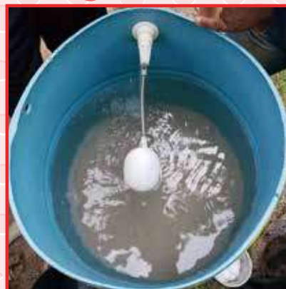
4 Boia instalada e água ligada
