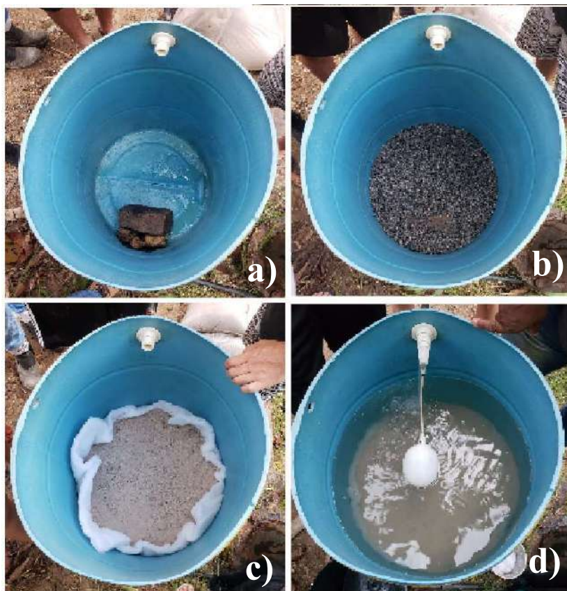
Figura 23 – Sequência de montagem do filtro: a) pedras de rio, b) brita zero, c) manta e areia e d) boia e ligação do sistema.
