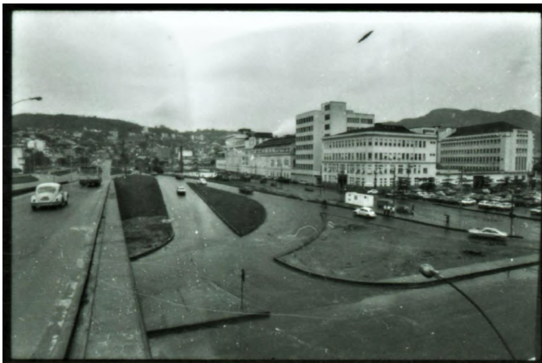
Figura 5 - Área do Sambódromo antes de sua construção e Cervejaria Brahma
