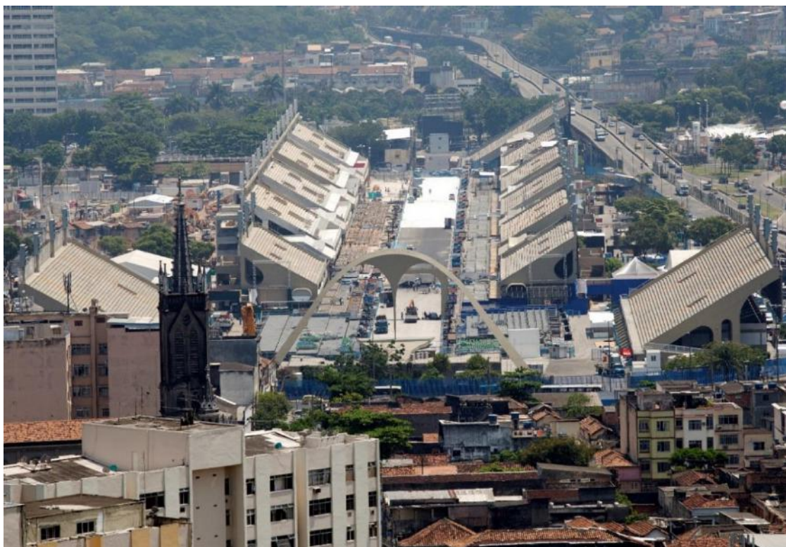
Figura 8 - Passarela Professor Darcy Ribeiro após a reforma
