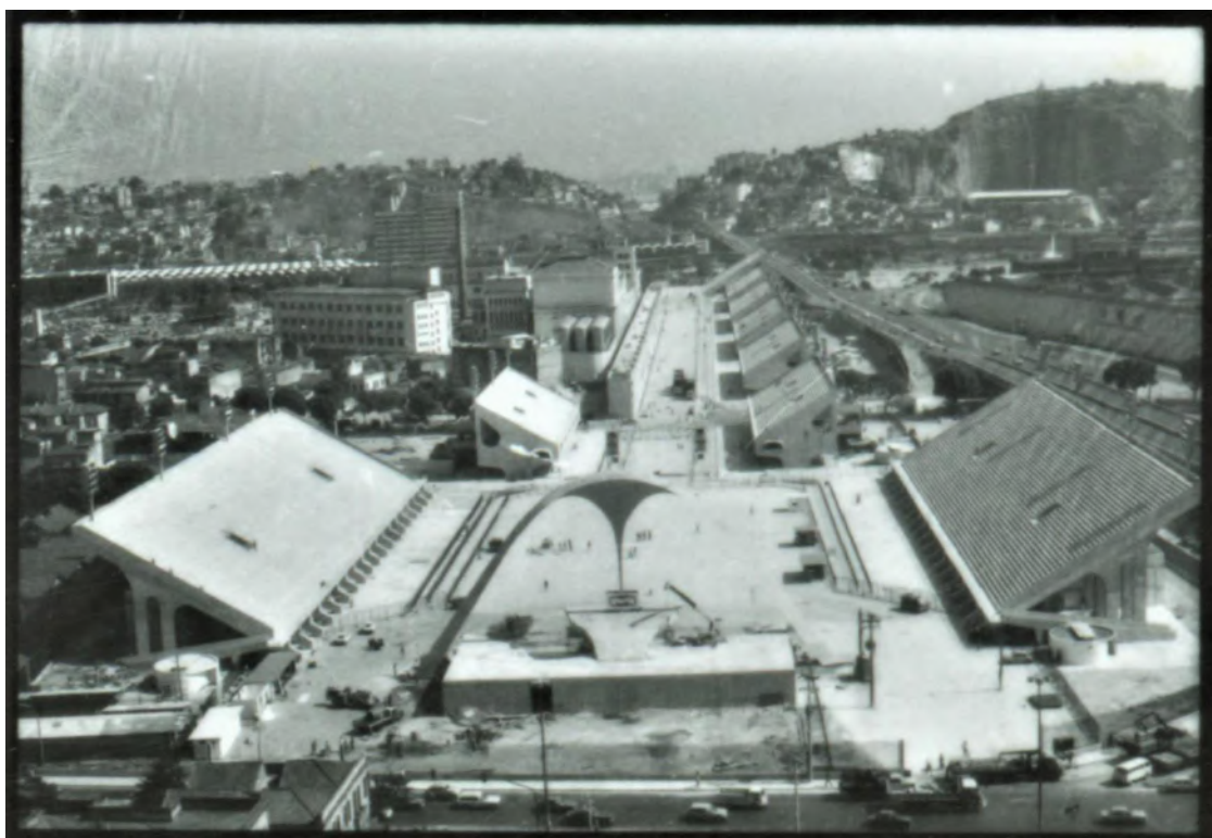
Figura 7 - Vista da construção dos camarotes do Sambódromo ao lado da Cervejaria Brahma
