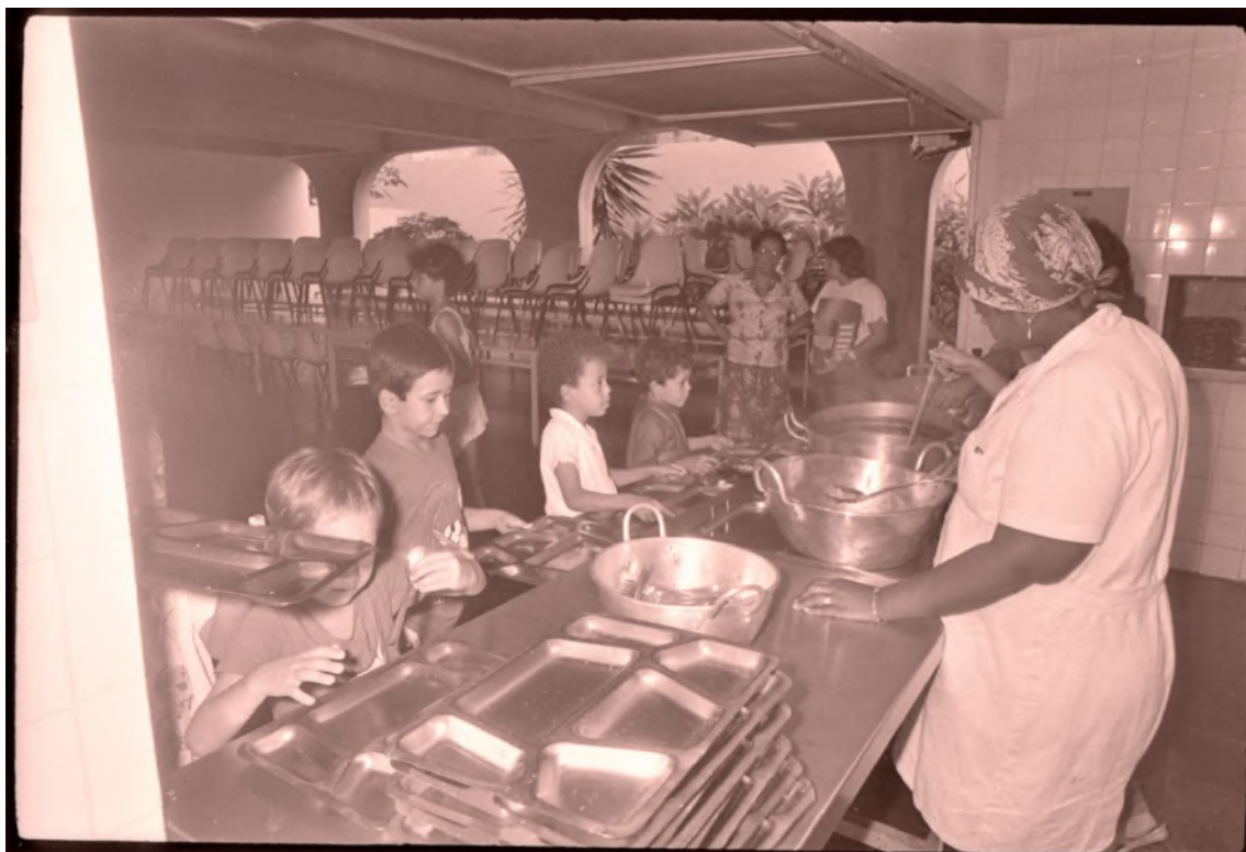
Figura 9 - CIEP Avenida dos Desfiles em funcionamento
