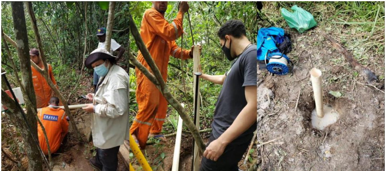
Figura 11 - Processo de perfuração e condicionamento dos poços.
