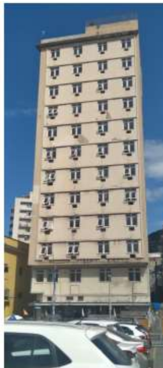
Figura 1 -Fachada do hotel Rio's Nice
