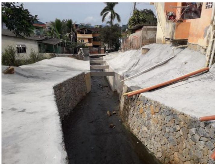
Figura 17. Rio do bairro Frade com muro de contenção. Fonte: https://angra.rj.gov.br/noticia.asp?vid_noticia=60320&t=Obras%20do%20canal%20do%20Frade%20pr%F3ximas%20da%20conclus%20E3o
