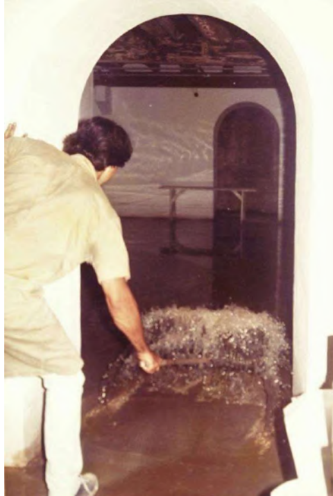
Figura 34 - Servidor tenta tirar água no porão do MCRB Fonte: Edmar Gonçalves
