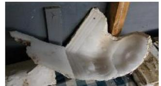
Fig.25 Partes da fôrma provisória da mísula.
