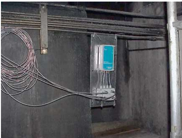
Figura 45 – Instalação Temporária de um sistema wireless de monitoração de mancais críticos (SKF, 2018)
