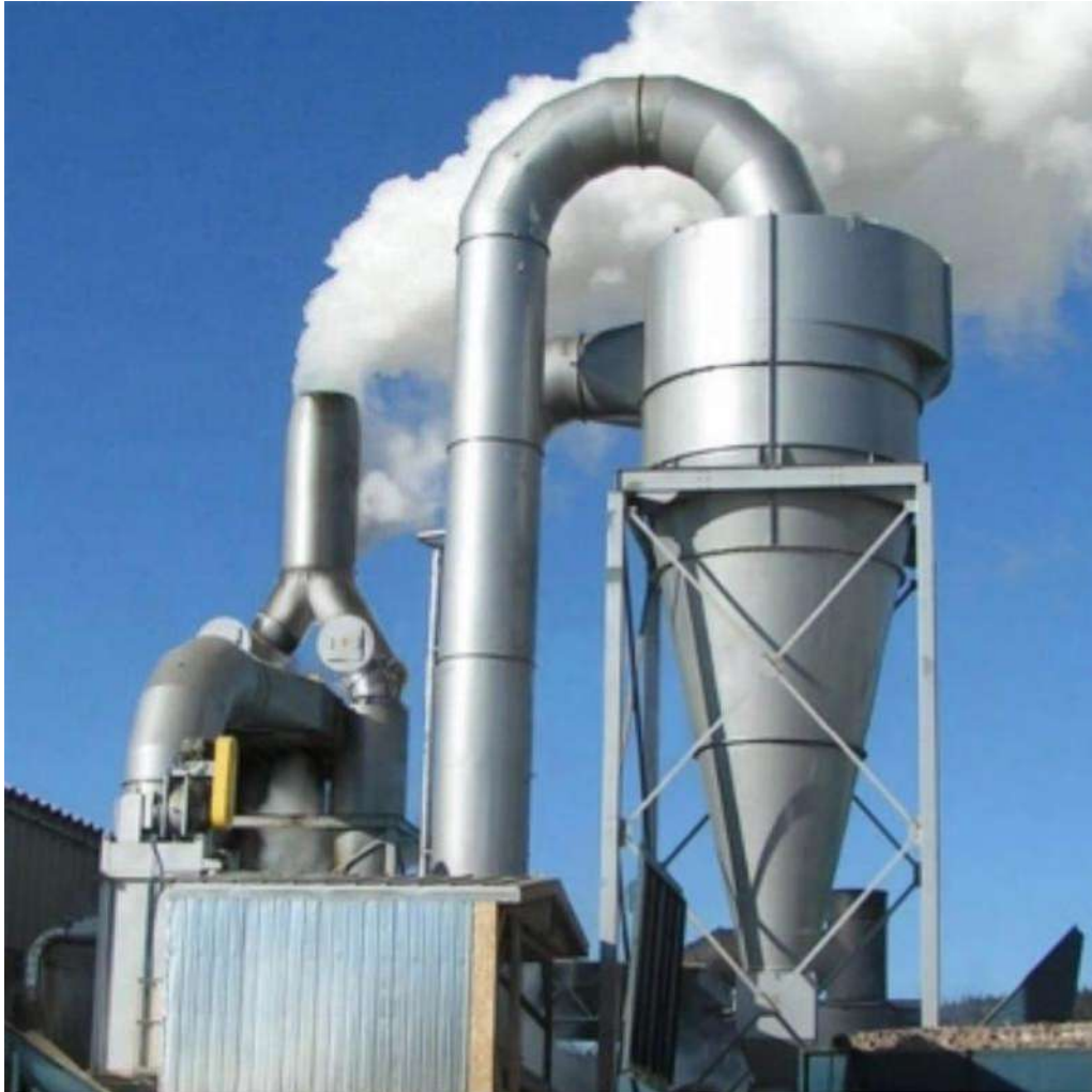
Figura 8: Ciclone de Uso Industrial
