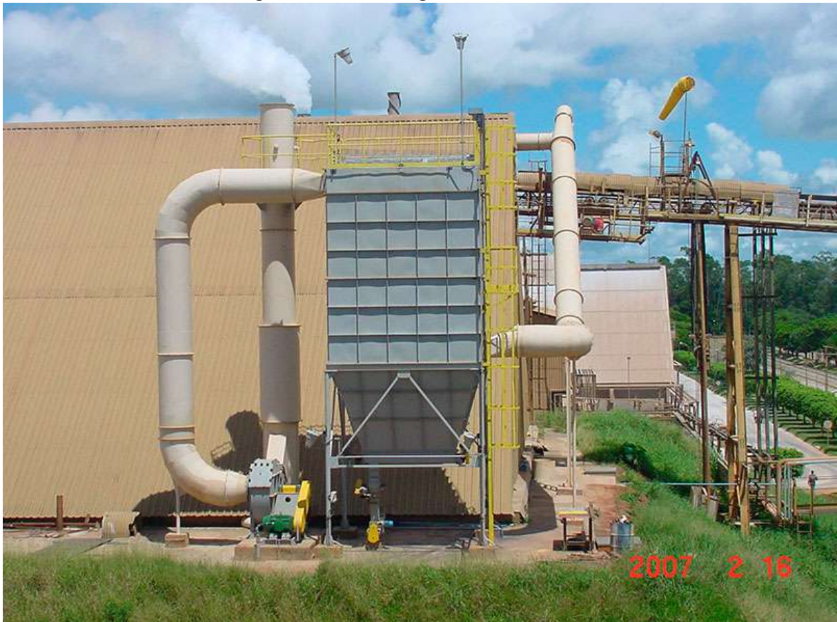
Figura 11: Filtro Manga de Uso Industrial
