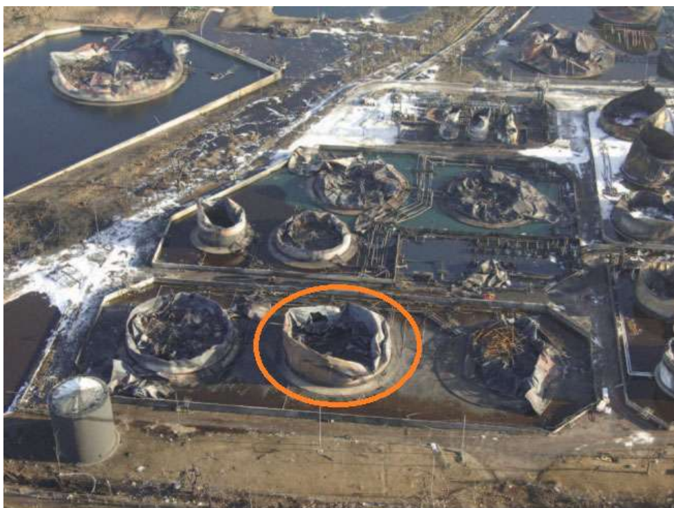
Figura 11: Tanque 912 (indicado em laranja) após o acidente. Adaptado do HSE, 2008
