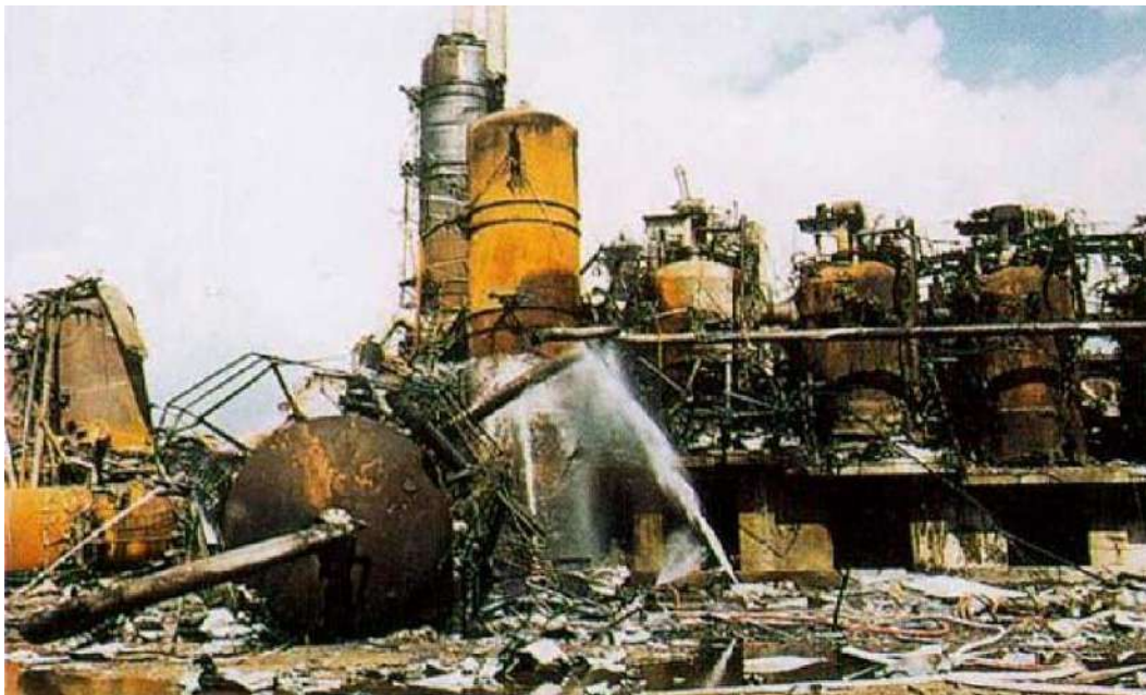
Figura 5 - Foto da planta destruída após o acidente.
