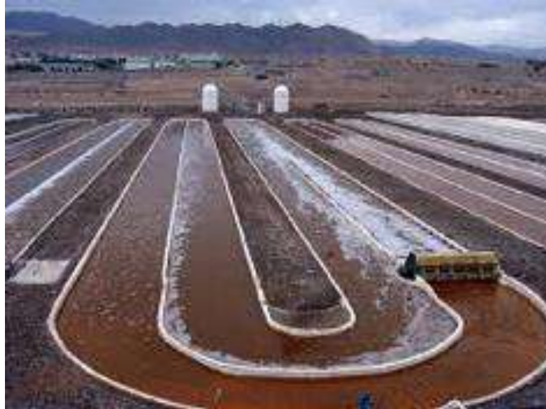
Figura 7. Sistema de lagoas abertas para produção de biomassa algal
