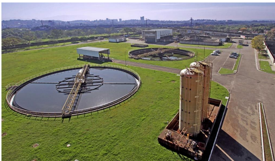
Figura 4 – Estação de Tratamento Pavuna (CEDAE, [s.d.]).
