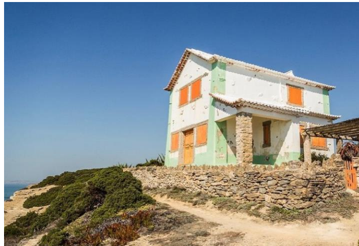
FIGURA 4 – Casa Branca em Azenhas do Mar, no litoral do município de Sintra. Construída em 1920, foi propriedade e residência de veraneio do próprio Lino.
