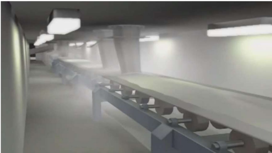
Figura 20: Esteira Transportadora com acúmulo de pó em suspensão (CSB, 2009)
