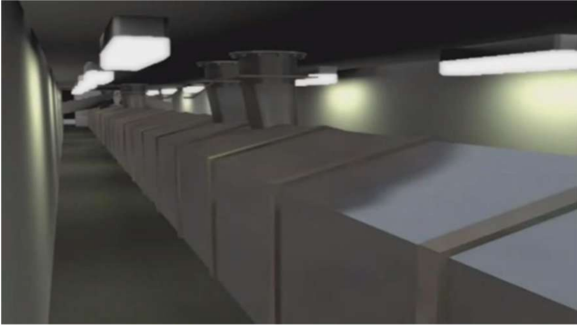
Figura 23: Adição de chapas de inox envolvendo a esteira (CSB, 2009)
