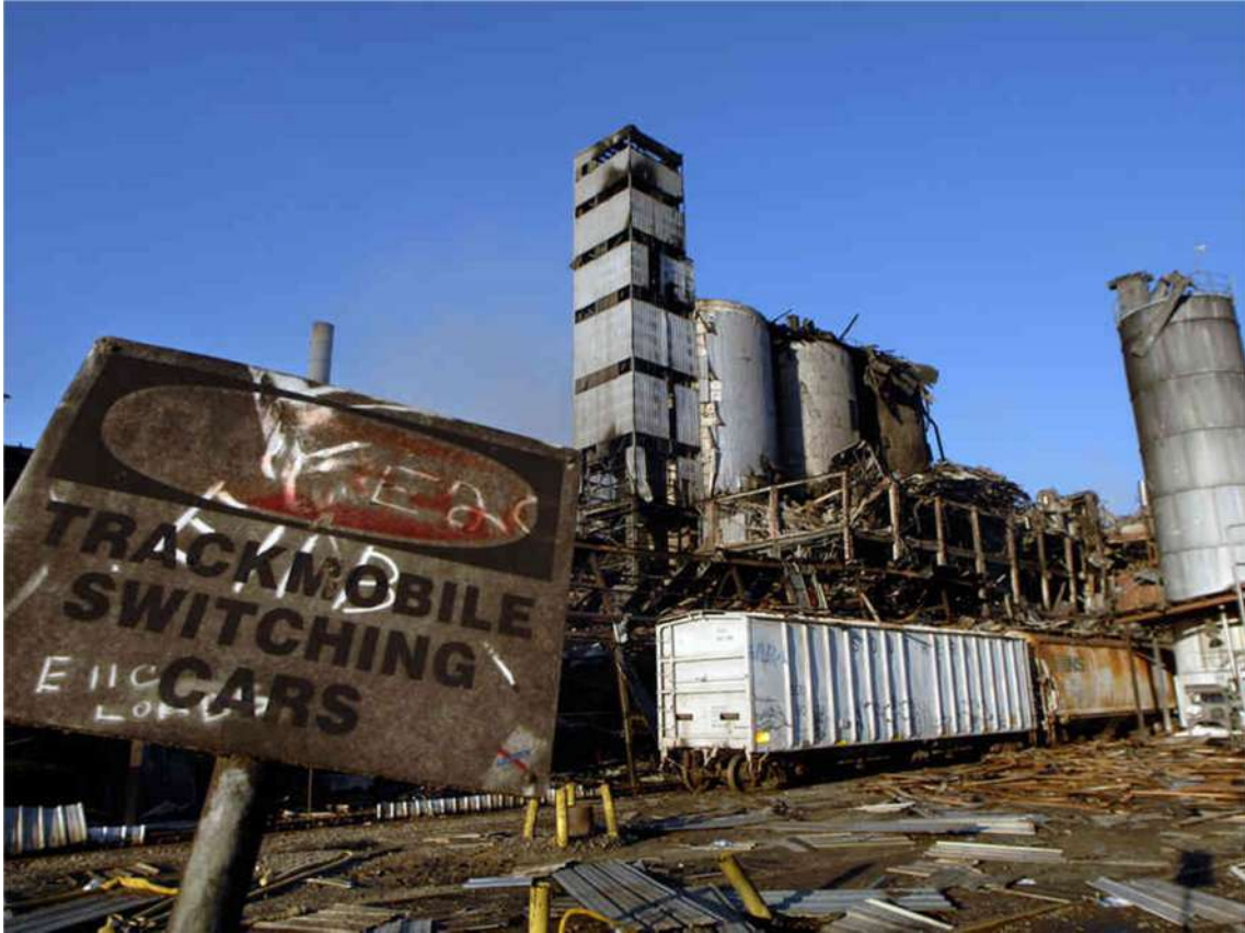
Figura 15: Foto da entrada da fábrica da Imperial Sugar após o acidente (CSB, 2009)
