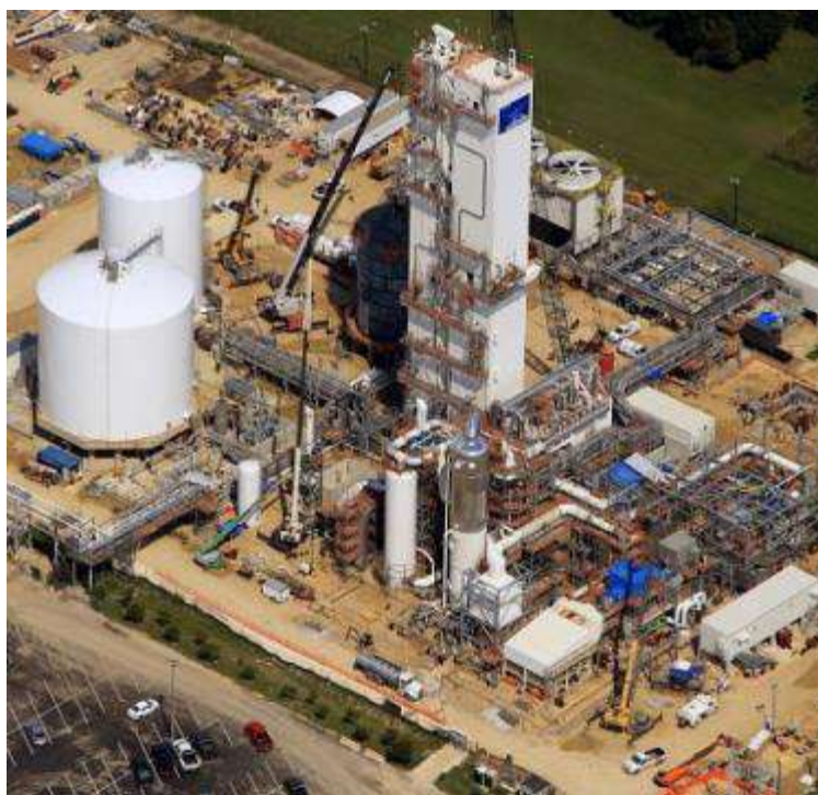
Figura 21 – Planta de destilação criogênica em fase de construção.
