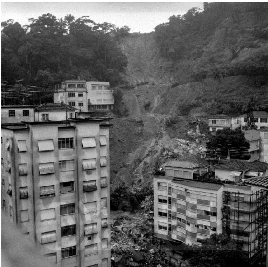
Figura 4.5 – Foto do desabamento na Rua General Glicério em 20/01/1967 (Fonte: http://www.rioquepassou.com.br/2010/01/02/rua-gal-glicerio-janeiro-de-1967/ ).
