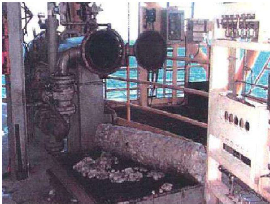
Figura 4 - Entupimento de tubulação devido à formação de hidrato. Fonte: Kunert et al. (2007)
