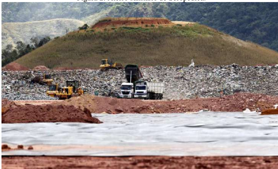
Figura 2: Aterro sanitário de Seropédica.
