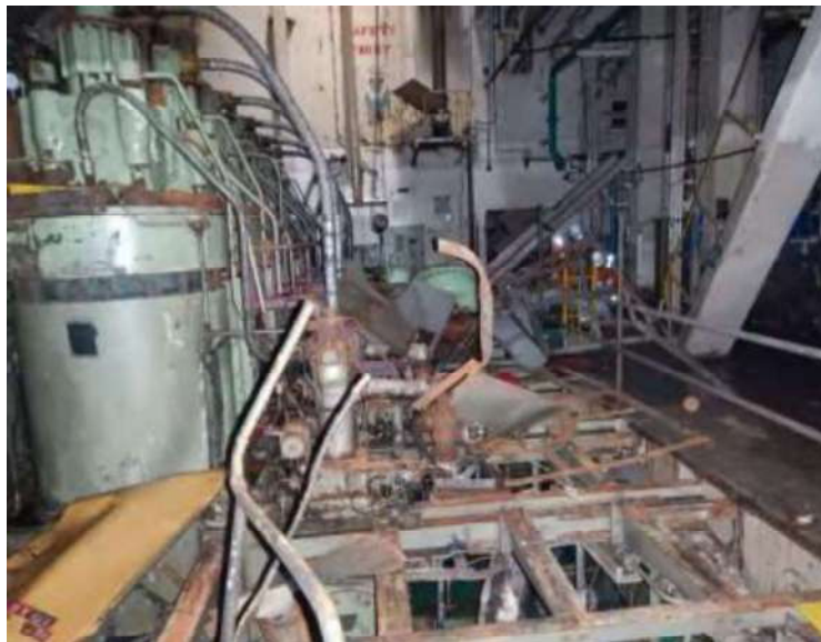
Figura 18 - Praça de máquinas destruída pelos efeitos da explosão.
