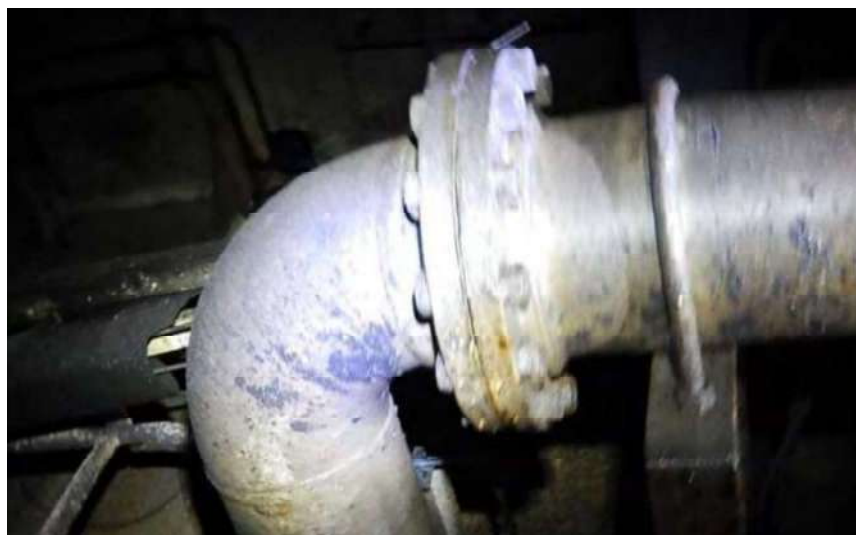
Figura 38 - Raquete instalada no flange próximo da válvula OP-068.
