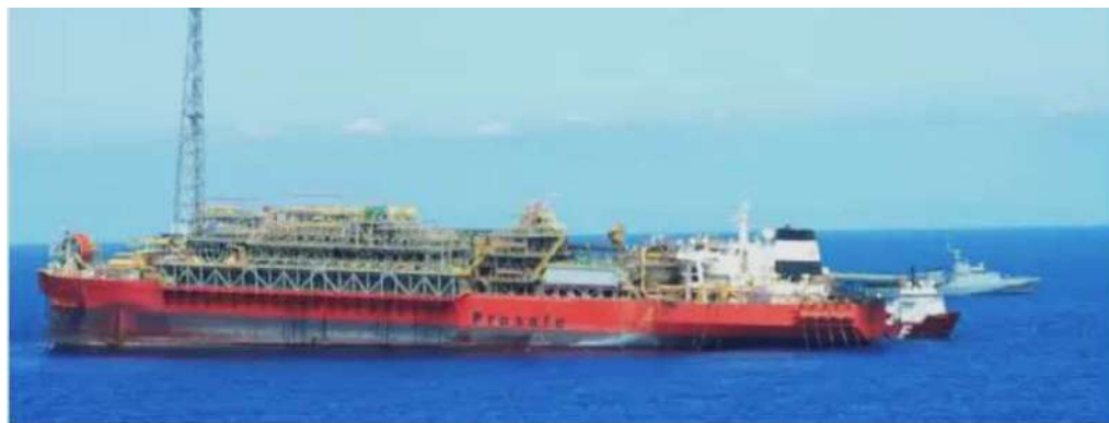
Figura 11 - Após o acidente no FPSO CDSM.
