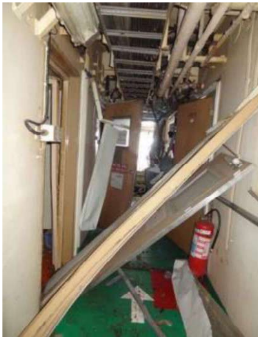
Figura 20 - corredor que dá acesso à sala de controle dentro do casario
