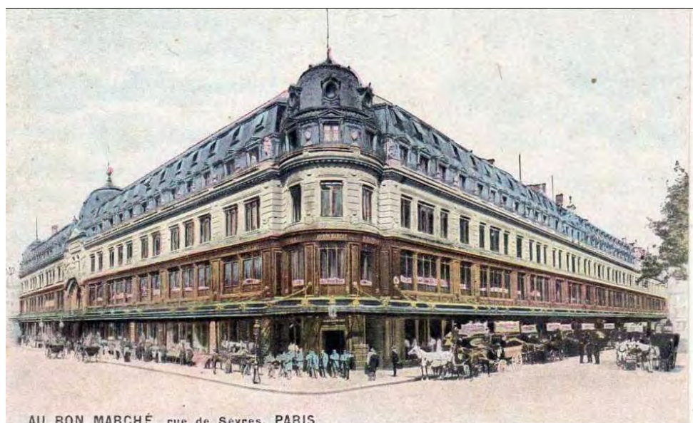
FIGURA 11 - Fachada da loja Le Bon Marché.
