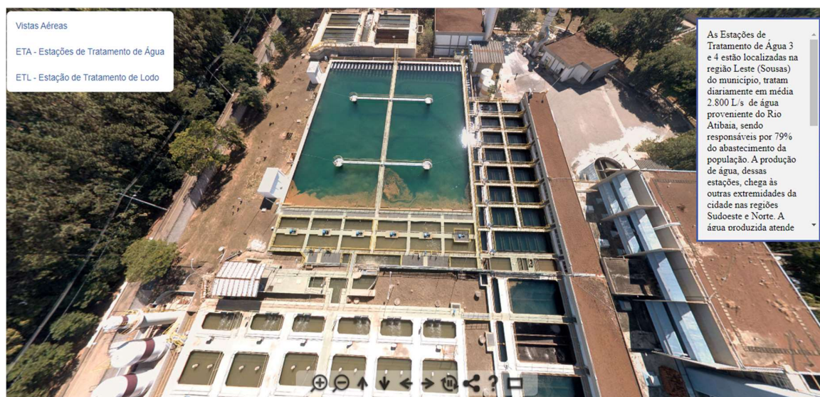
Figura 9. Simulação de visita técnica na estação de tratamento.
