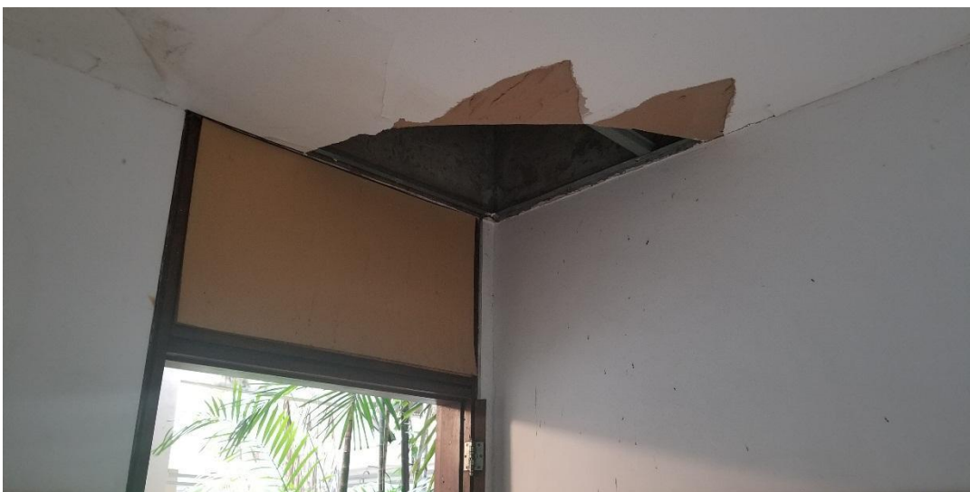
Figura 10: Fragmento da estrutura física da edificação administrativa
