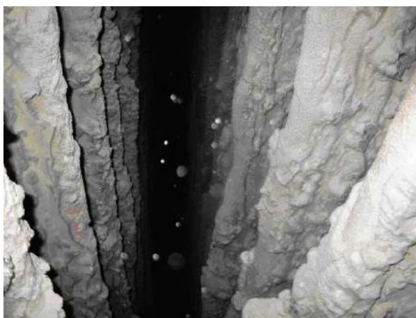
Figura 16: Formação de depósitos de material particulado nos superaquecedores de uma caldeira de recuperação Kraft. FONTE: VAKKILAINEN, 2005.
