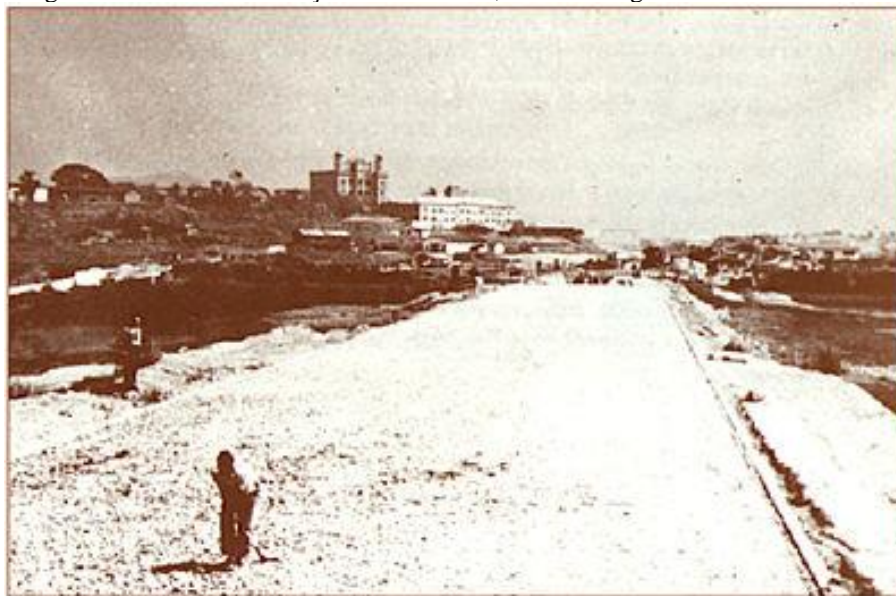
Figura 11. Obra de construção da Av. Brasil, trecho Manguinhos. s/autor. c. 1940
