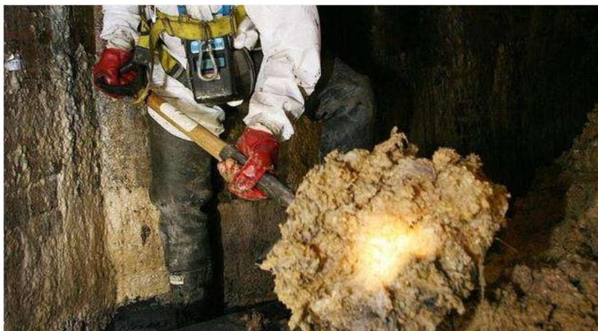
Figura 15: Limpeza de uma galeria de esgoto entupida. Fonte: BICOLETA, 2013.
