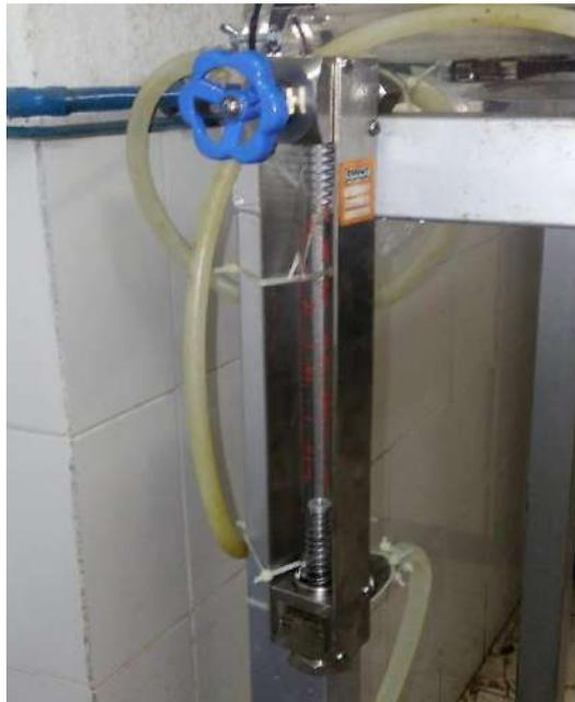
Figura 3.3 – Rotâmetro acoplado com válvula agulha.
