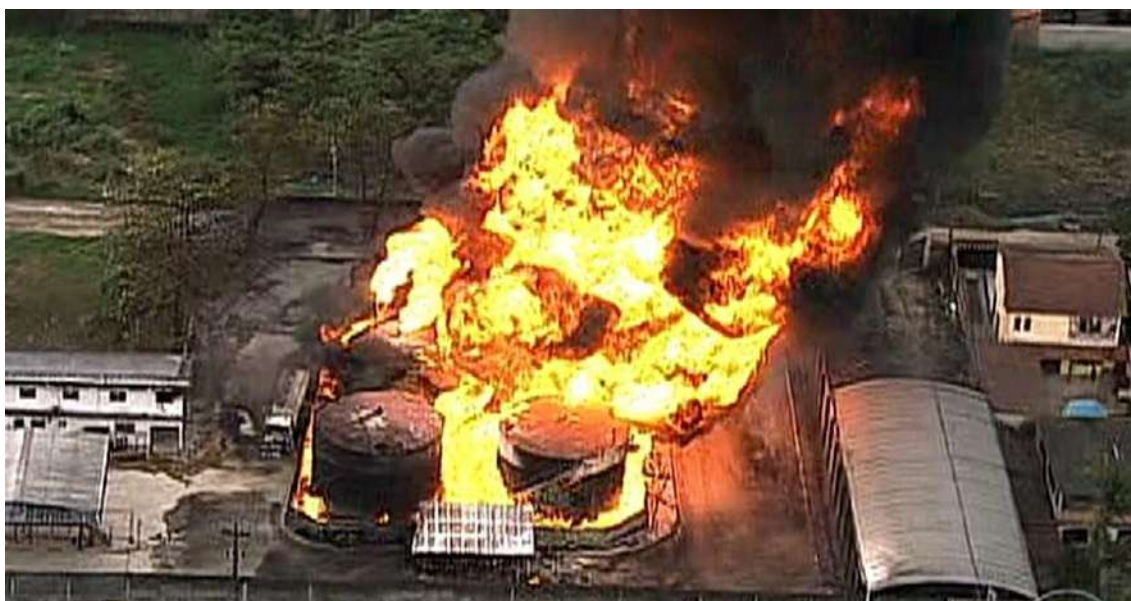
Figura 11 - Incêndio em poça nos diques e tanques da Petrogold Fonte: G1 (2013)
