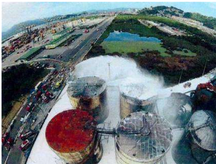
Figura 7 - Combate ao incêndio por uso da espuma cold fire Fonte: Diário Oficial do Estado de São Paulo (2015)
