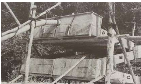
Figura 18 - Calha concentradoras. Fonte: Sampaio, J.A. ; Santos, R.L.C, 2014, p. 80.
