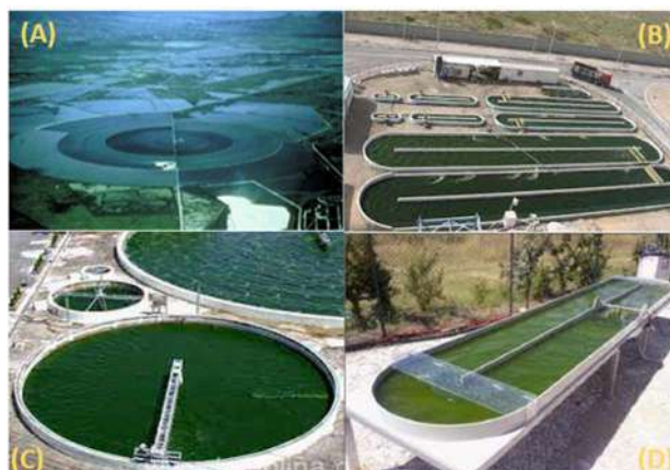
Figura 5 –Imagens reais de sistemas abertos de cultivo de microalgas.
