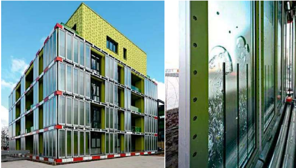
Figura 1.1 – SolarLeaf: Edifício com fachada recoberta por fotobiorreatores
