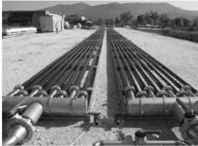
Figura 2.5 – Exemplo de fotobiorreator tubular tipo manifold .
