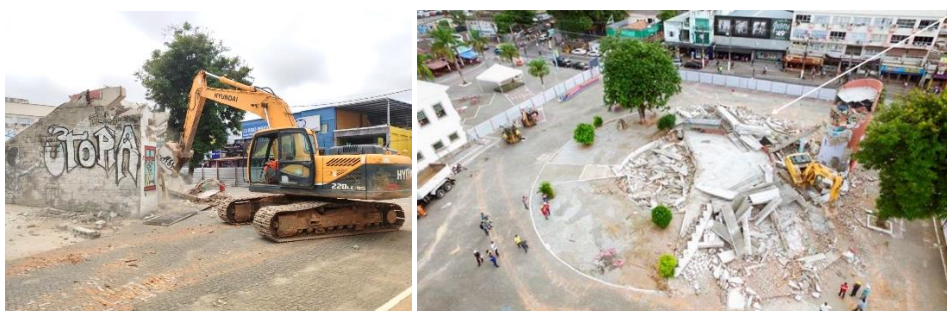
Figura 70: Demolição do Anfiteatro vista aérea.
