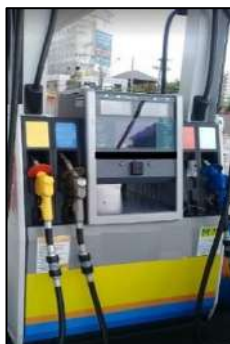
Figura 4.6 – Bomba de abastecimento. Fonte: Autor
