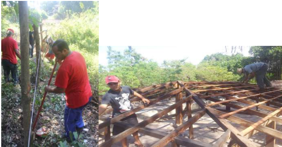
Mutirões para confecção da cerca e recuperação do telhado
