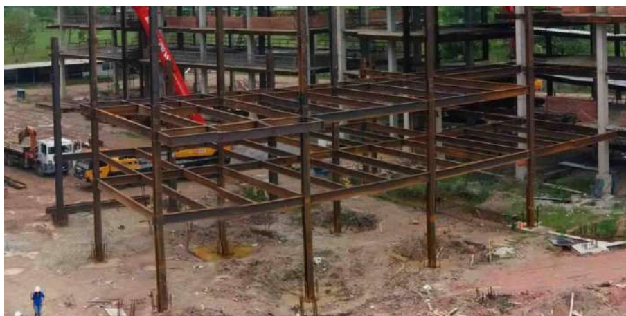
Figura 6: Sequência lógica de montagem com ciclo a cada 2 andares. [22]
